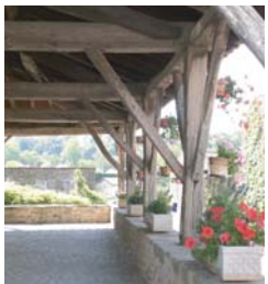
Halle de Saint-Pardoux
